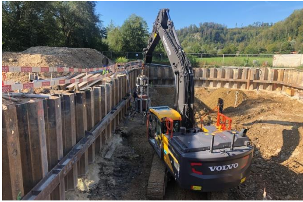
Abb. 1: Baugrube MWB Jostenmatten, Stand September 2019
